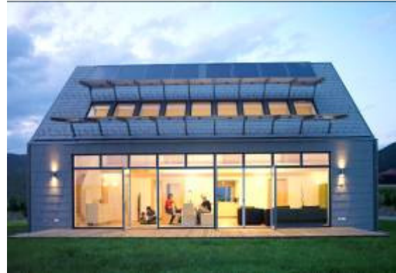
Tageslicht, frische Luft und eine gesunde Umwelt – ohne Heizkosten
