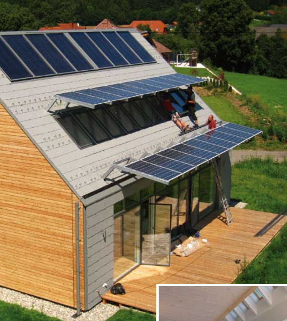
Dachflächenfenster zur Tageslichtnutzung werden mittels PV nur im Sommer beschattet.
